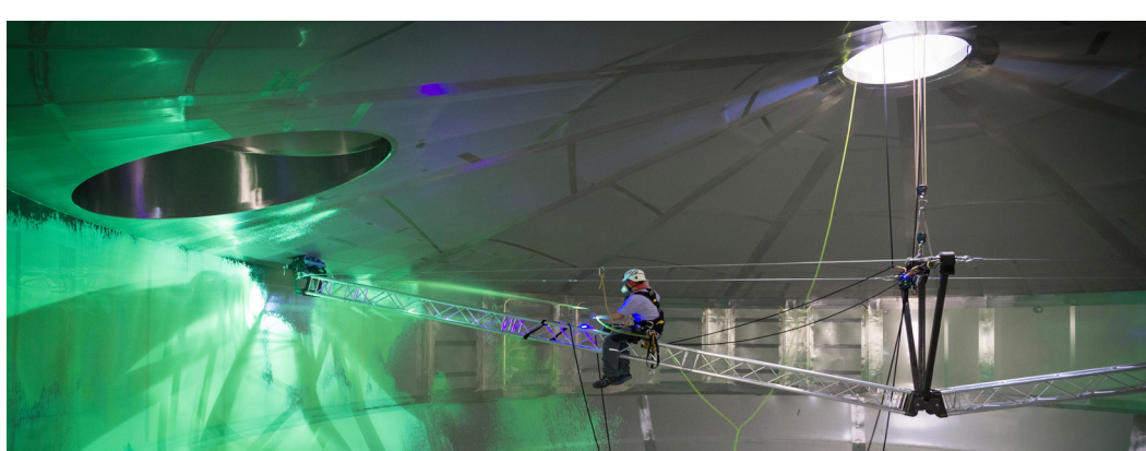
Fuldtanksinspektion udført med "Rope Access".
